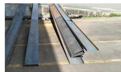
Perfis metálicos para substituição da estrutura do mezanino
