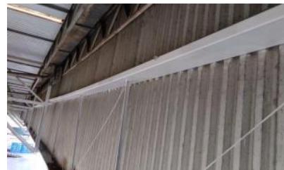
Recuperação e Pintura da estrutura do telhado
