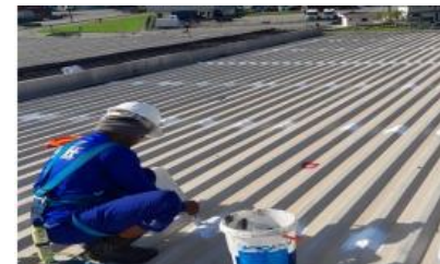
Aplicação da manta líquida
