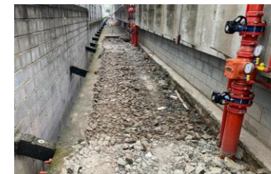
demolição do piso de concreto
