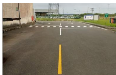
Pintura da sinalização horizontal (viário)
