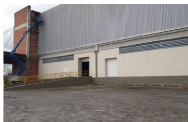
Pintura do galpão Praia do Forte
