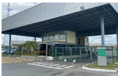
Revitalização e pintura da portaria
