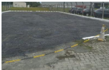
Extensão do estacionamento de veículos leves
