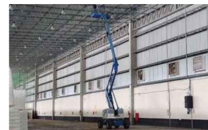
Estrutura metálica recuperada e pintada
