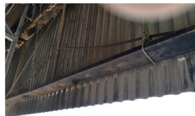
Instalação dos perfis metálicos novos
