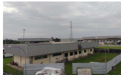
Reforma do refeitório
