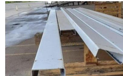
Preparação das peças da estrutura metálica
