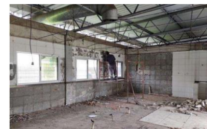
Remoção do forro e revestimentos do restaurante
