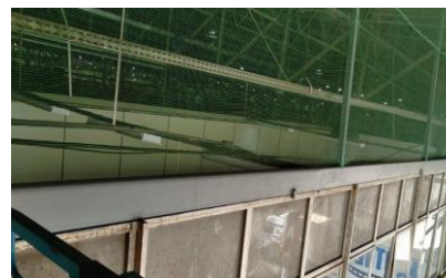
Instalação da tela mosquiteiro
