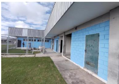
Entrada do refeitório
