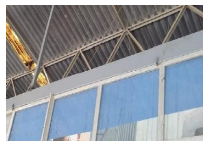
Recuperação e pintura das peças metálicas
