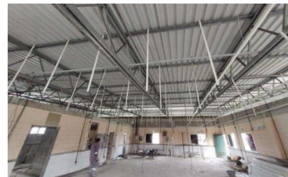
Reforma do refeitório
