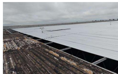
Substituição das telhas estruturais
