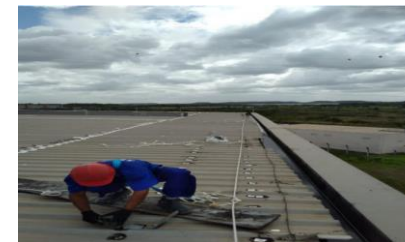
Galpão Itapuã (depois)
