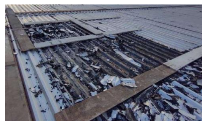
Galpão Praia do Forte (antes)
