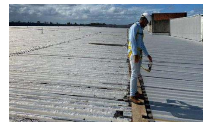
Galpão Praia do Forte (depois)
