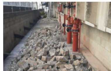
Demolição do piso de concreto
