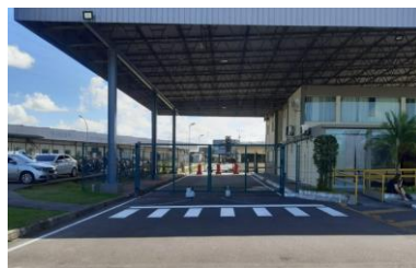
Pintura da sinalização horizontal (viário)
