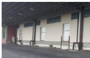
Pintura do galpão Praia do Forte
