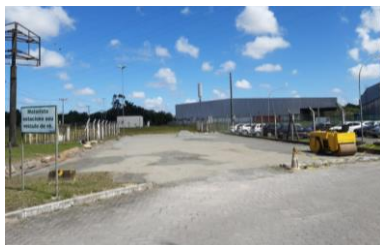
Extensão do estacionamento de veículos leves
