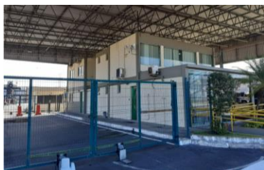
Revitalização e pintura da portaria
