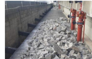
Demolição do piso de concreto
