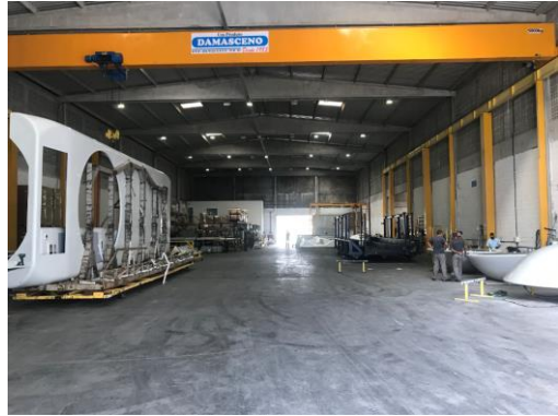
Vista Geral – Galpão 6
