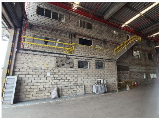
Escada de Acesso ao Mezanino
