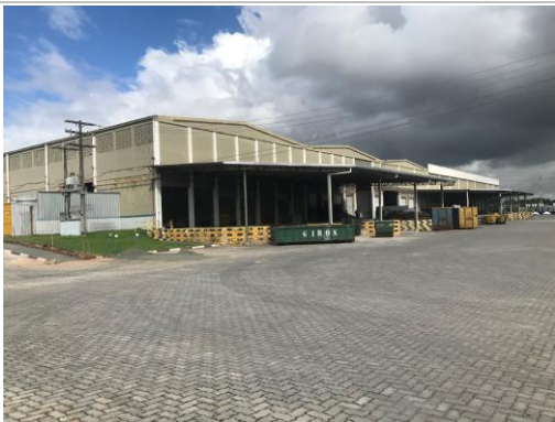
Vista Geral - Fachada
