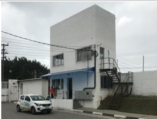
Vista Geral – Portaria
