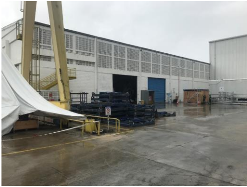
Vista Geral – Fachada
