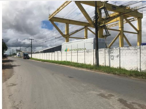
Vista Geral - Fachada
