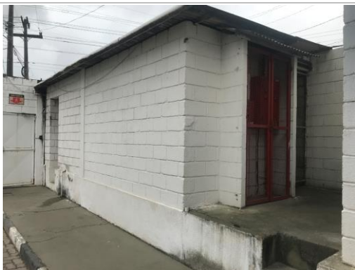
Vista Geral – Casa de bombas – Combate a incêndio
