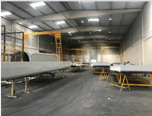
Vista Geral – Galpão 7
