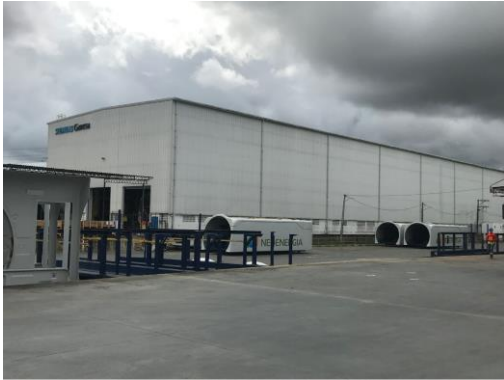
Vista Geral – Fachada
