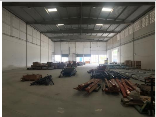
Vista Geral – Galpão 5
