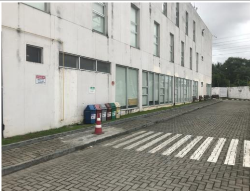
Vista Geral - Fachada
