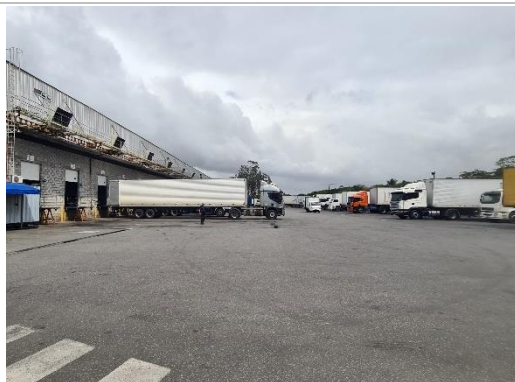
Pátio e área externa do Galpão
