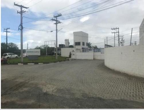
Vista Geral - Entrada
